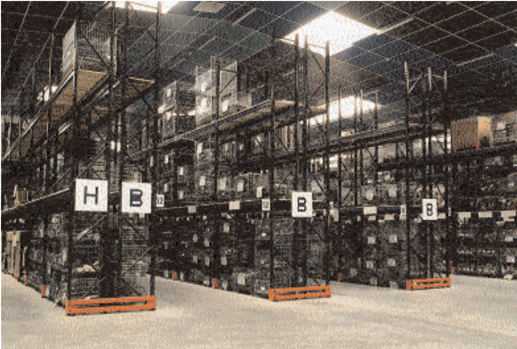
Vue générale d'une installation de stockage.
