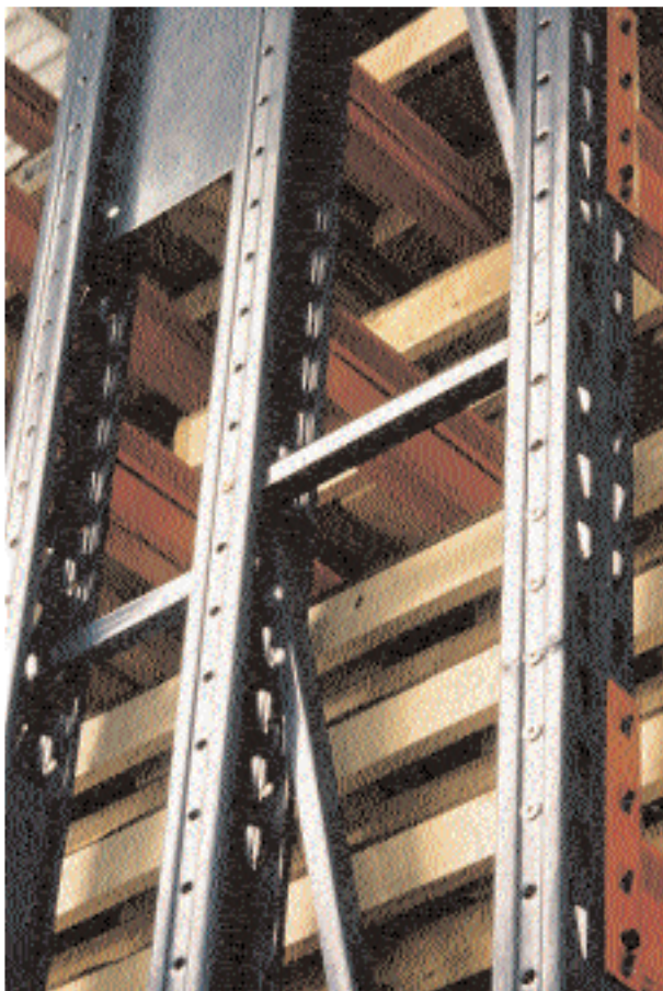
Structure d'une installation de stockage.
