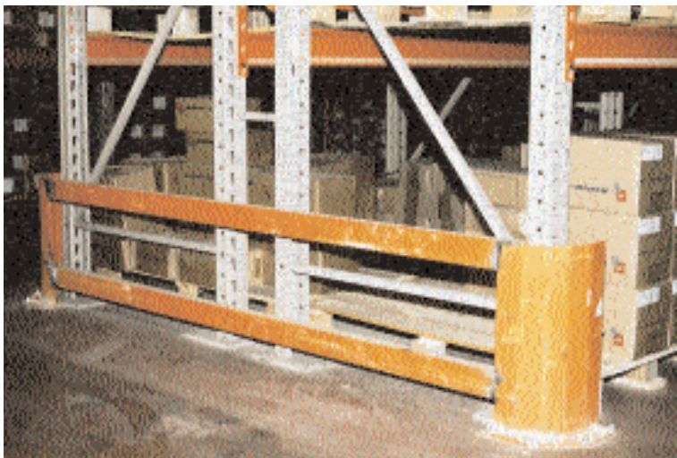
Protection des pieds d'échelle d'extrémité.
